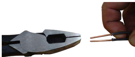
ภาพที่ 1.35 ปอกฉนวนสายไฟประมาณ 2.5 ซม.
